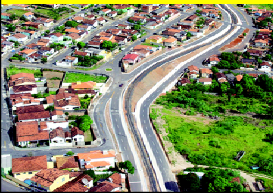
Margem da Estrada de Ferro- Av. Nicolau Abrão
