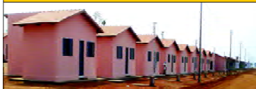
268 casas em construção no Jardim Evelina Nour.
